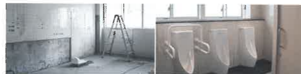
R2 トイレ改修工事（写真左）。改修後はバリアフリーの使いやすいトイレになった。（写真右）
